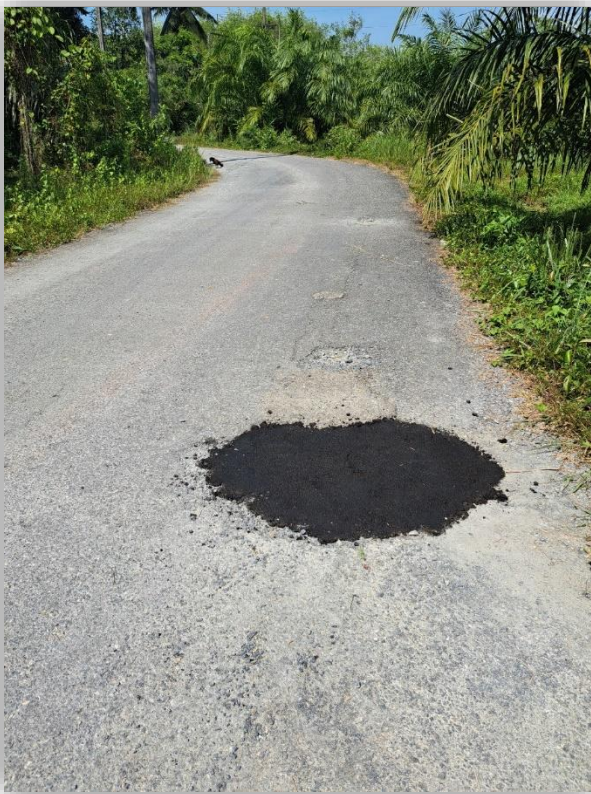
เป็นวัสดุซ่อมแซมถนนคอนกรีตแทนยางมะตอย
